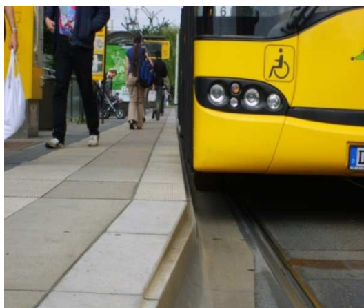
Rys. 9.8.2.1. Zalecane ukształtowanie krawędzi peronowej.
